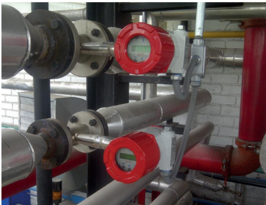
**Zusätzliche Sensoreingänge** ermöglichen es beispielsweise, eine zweite Temperaturmessung zu erfassen und eine Energieverbrauchsmessung durchzuführen. Diese ermöglicht Ihnen ein effizienteres Betreiben Ihrer Anlage.
