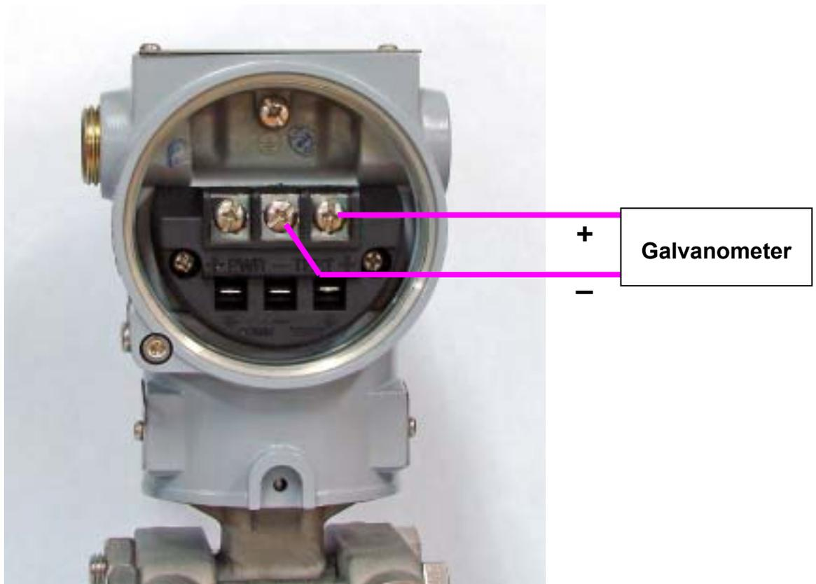
Abbildung 7.1: „TEST“-Klemmen (Prüfklemmen)
